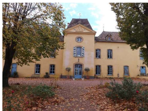
Façade nord-est du château correspondant à la façade noble du temps où ce dernier était accessible par le chemin de Sainte-Marie.
